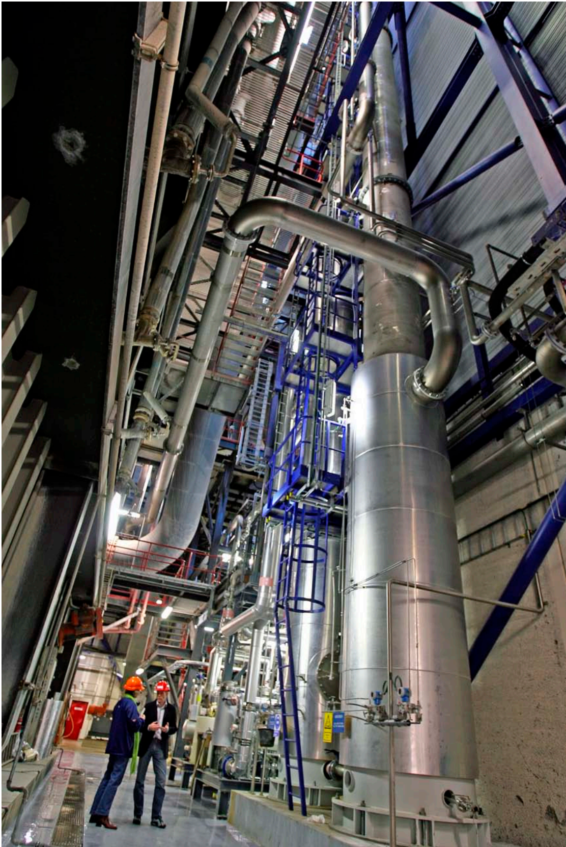
Figur 2.36 Absorber av Esbjerg-pilotenhet (Kilde: DONG Energy Power).
