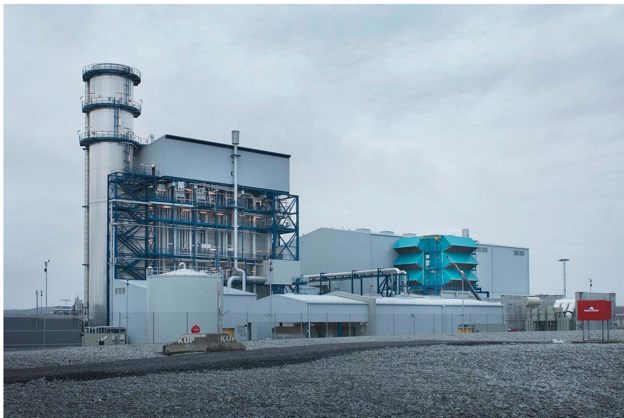
Figur 2.35 Gasskraftverket på Kårstø.
