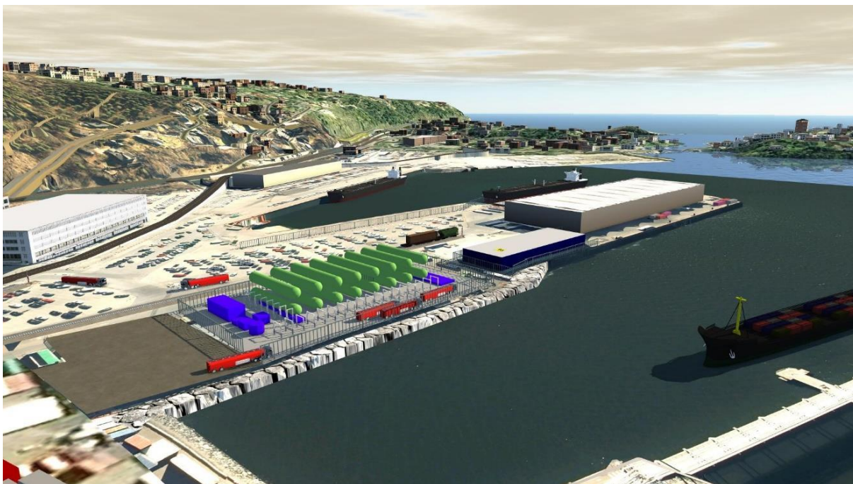
Figur 4-19: 3D-bilde fra nordvest som viser mellomlageret på Kneppeskjær og CO 2 -skipet i bakgrunnen.
